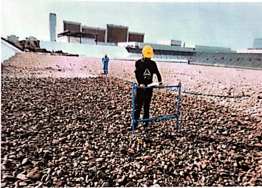
图 3-2 填埋库区底部双电极法现场渗漏探测
