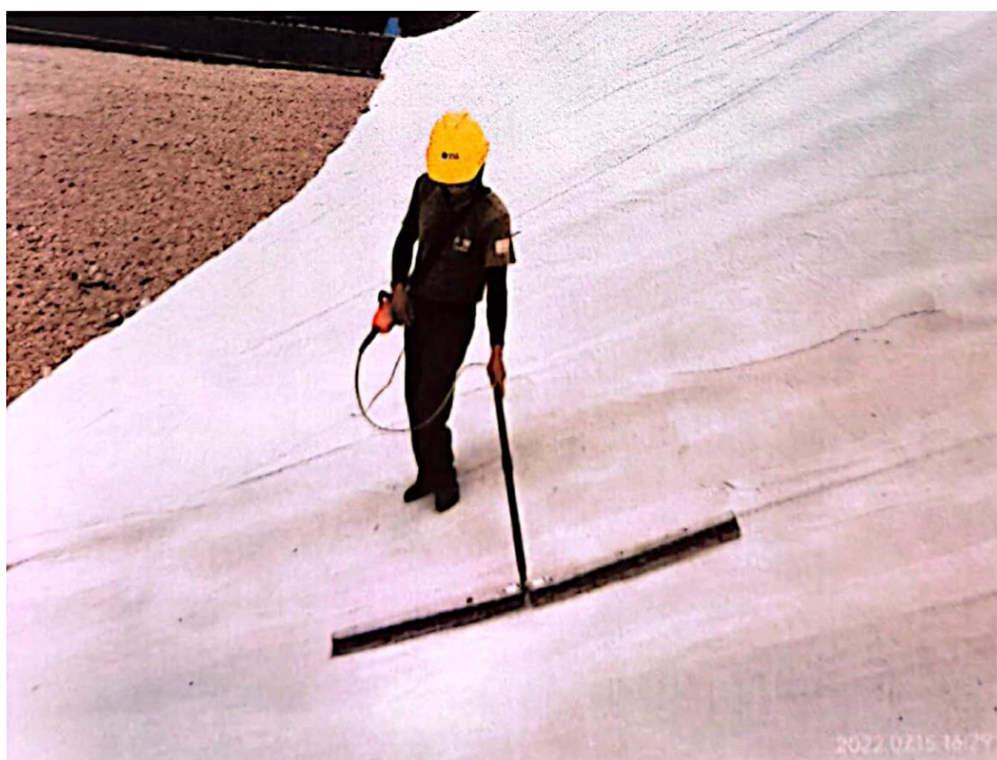
图 3-13 防渗系统完整性检测过程图
