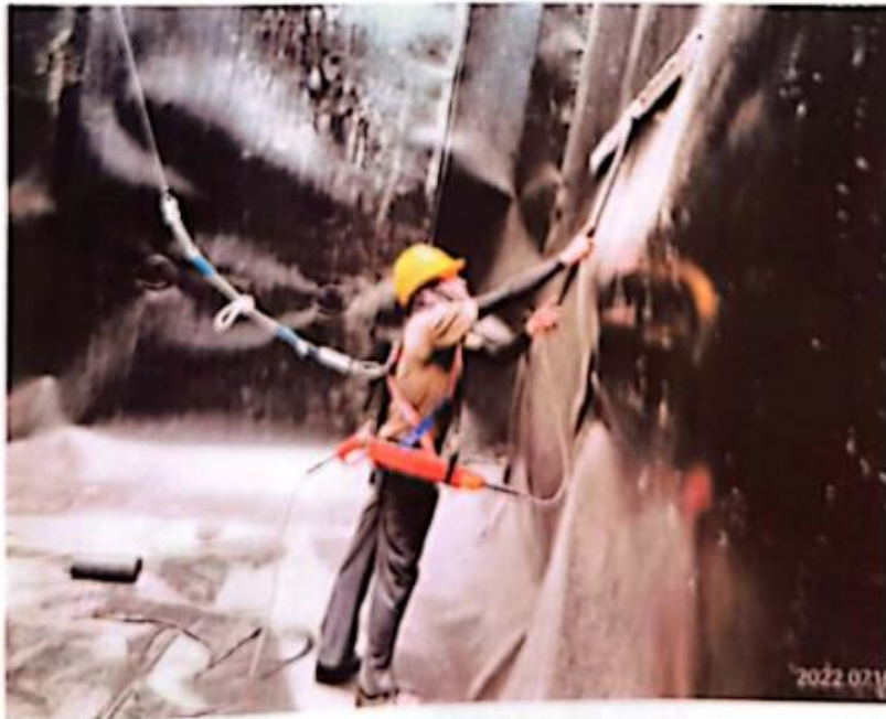
图 3-3 单元池池壁渗漏探测现场
