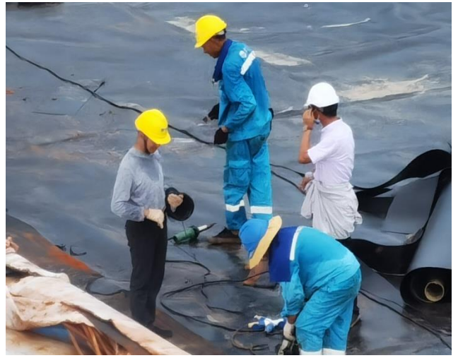
库底防渗层施工
