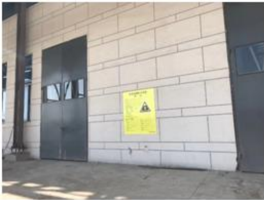
一期危废库外部
