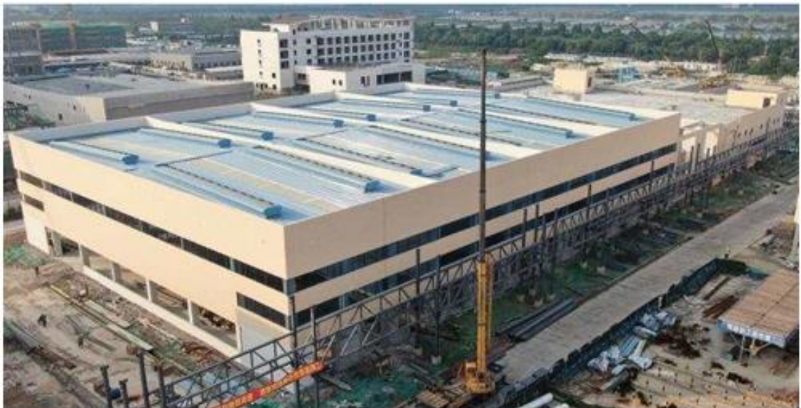
一期危废库全景
