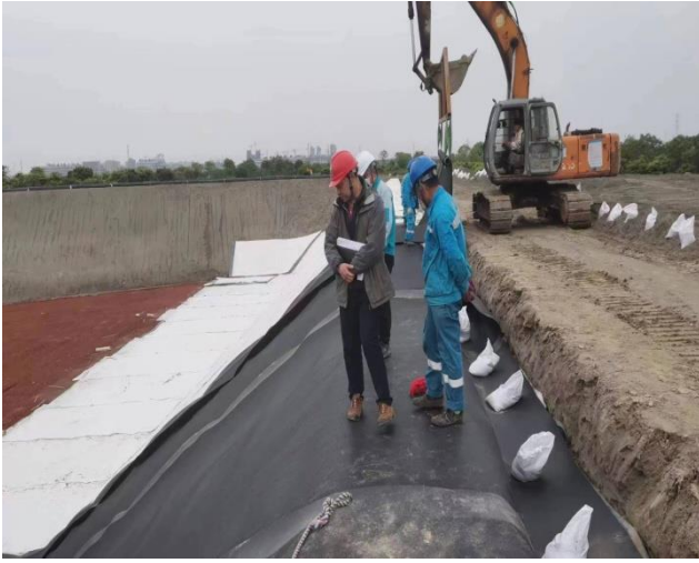
围堤防渗施工
