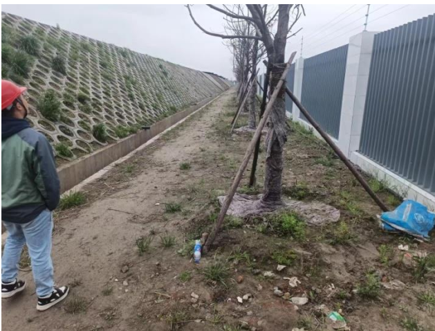
边坡施工及绿化工程
