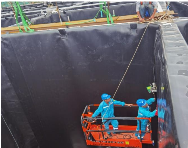
挡墙防渗工程
