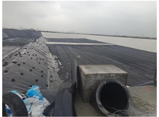
渗滤液提升施工
