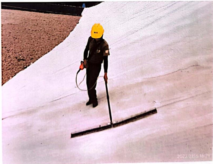
图 3-3 填埋库区边坡电弧法渗漏探测
